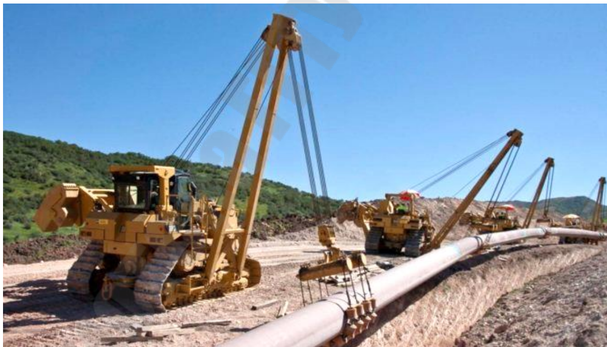
Рис. 1.4 Трубоукладочная колонна на укладке трубопровода в траншею
