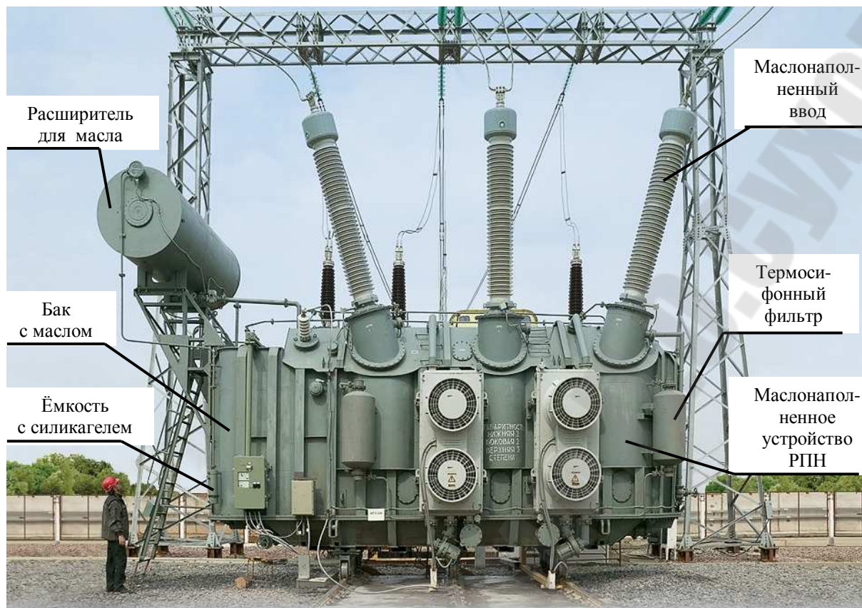
Рис. 11.1. Элементы с трансформаторным маслом в высоковольтном силовом трансформаторе
