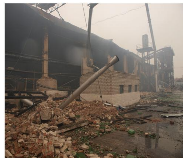
Рисунок 1 – Повреждения стен и покрытия производственного здания
