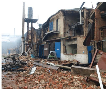
Рисунок 1 – Повреждения стен и покрытия производственного здания
