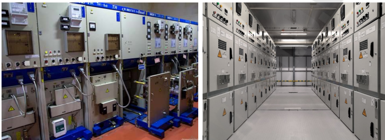
Рис. 7.2 Модификации КРУ
