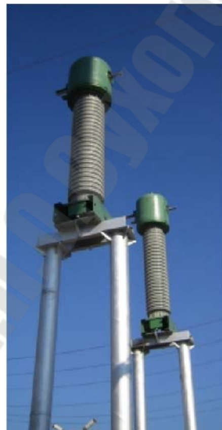
Рис. 6.6. Элегазовый трансформатор тока ТГФ-220
