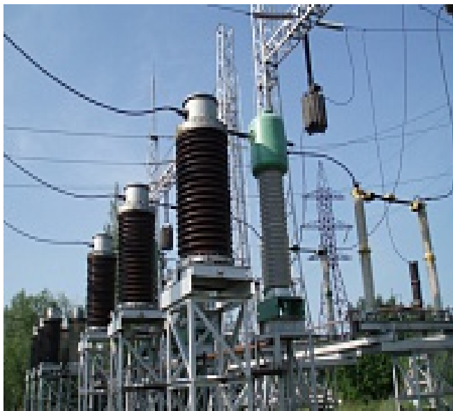
Рис. 6.5. Трансформаторы тока наружной установки:
