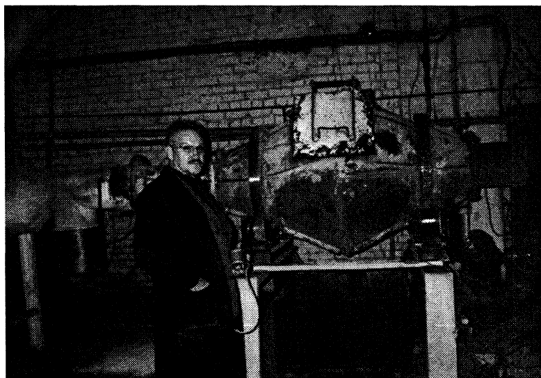
Рис. 1. Ротационная установка для сушки разнодисперсных металлоотходов в литейном цехе ООО «Эрни», г. Волковыск
