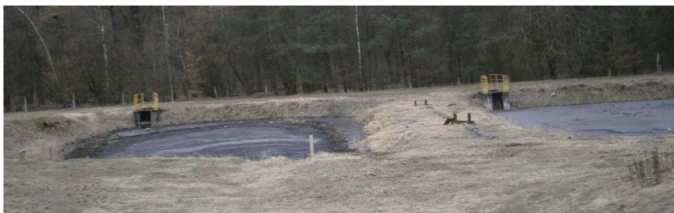
Рис. 2.9. Иловые площадки очистных сооружений г. Мосты (2019 г.)
