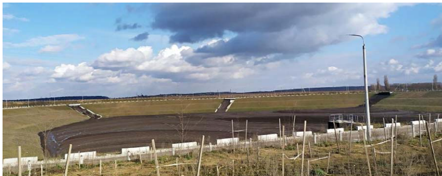
Рис. 2.4. Новая иловая площадка под складирование избыточного ила с очистных сооружений Минска
