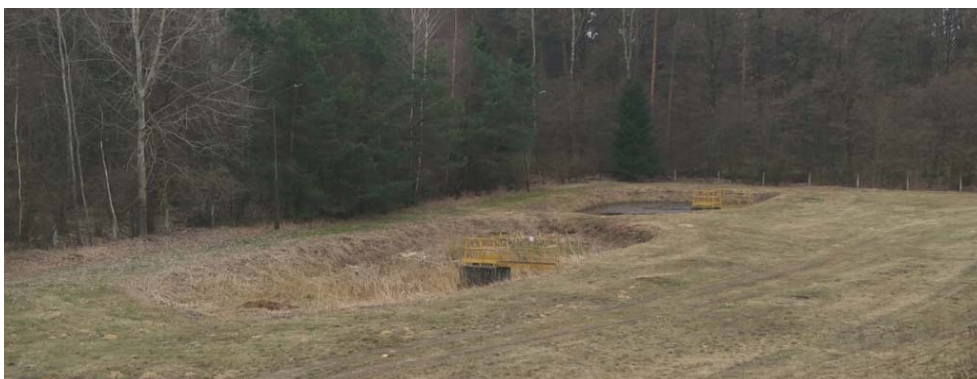
Рис. 2.8. Песковые площадки очистных сооружений г. Мосты (2019 г.)
