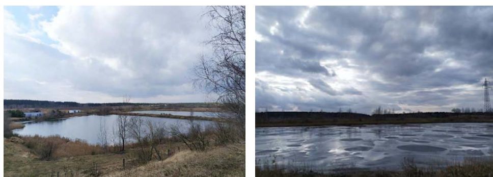
Рис. 2.2. Иловые пруды Минской очистной станции в Минском районе (около д. Синило)
