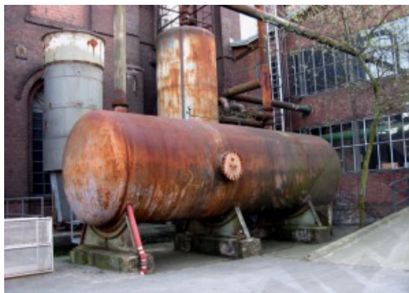
Рис. 7.2. Объекты анодной защиты.
