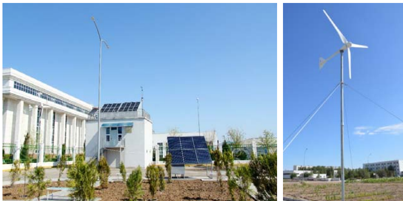
а) Рис. 1. «Энергосберегающий» жилой экспериментальный дом (а) и ветреная электрическая станция мощностью 2 кВт (б)
