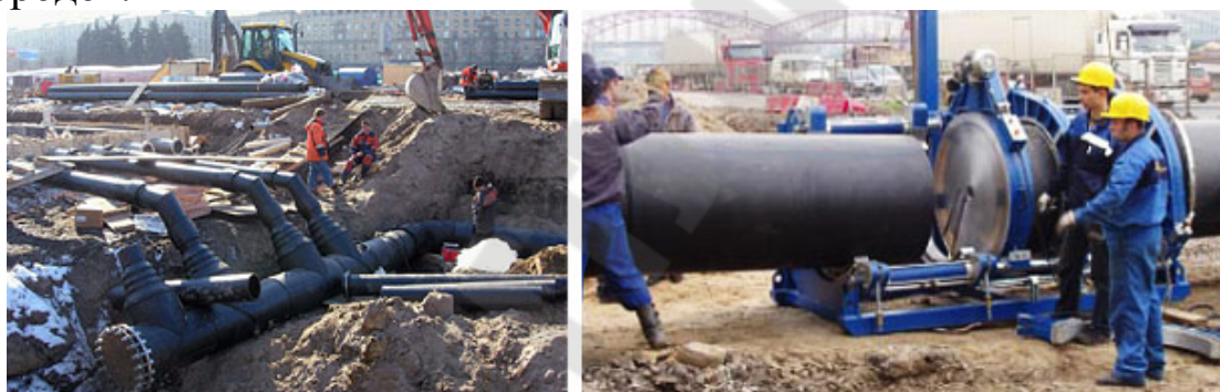
Рис. 1.4. Монтаж полимерных трубопроводов контактной сваркой
