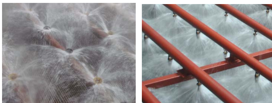
Рис. 7. Работа градирни с соплами старой и новой конструкций
