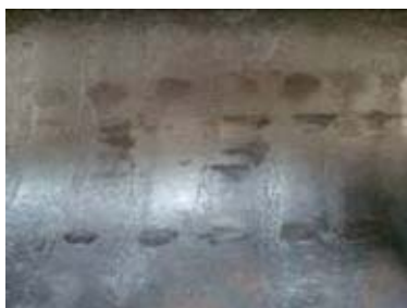
Рис. 3. Внутренняя поверхность реверсионной трубы
