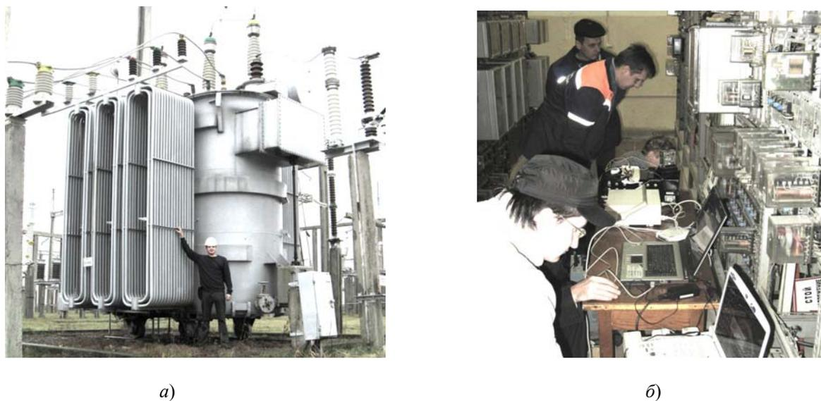
Рис. 1. Объект исследования: а – трансформатор; б – инженеры электрических сетей осуществляют подключение средств измерений в релейном зале подстанции
