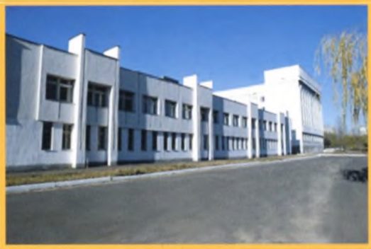
Корпус опытно-экспериментального производства Experimental production building
