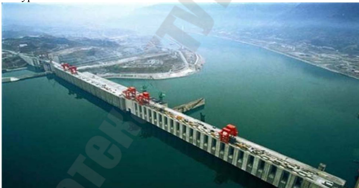
Рис. 5.5. Гидроэлектростанция «Три ущелья»
