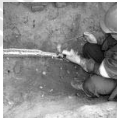
Рис. 10.10. Монтаж муфты СТП-10
