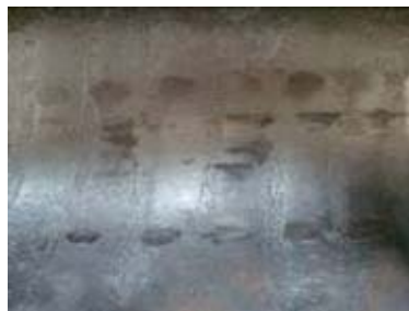
Рис. 3. Внутренняя поверхность реверсионной трубы
